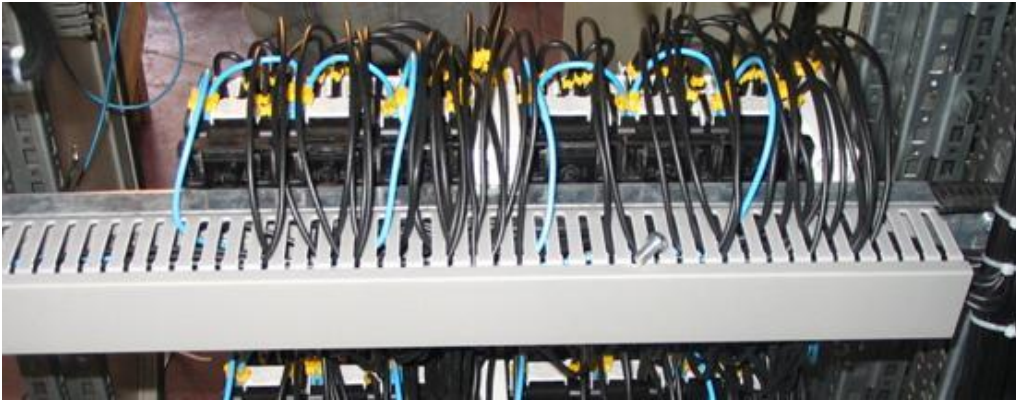
Resim 4.2: Kanal içine yerleştirilme işlemi tamamlanmış kablolar
