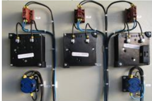
Resim 4.3: Kumanda kablolarına form verilmesi
